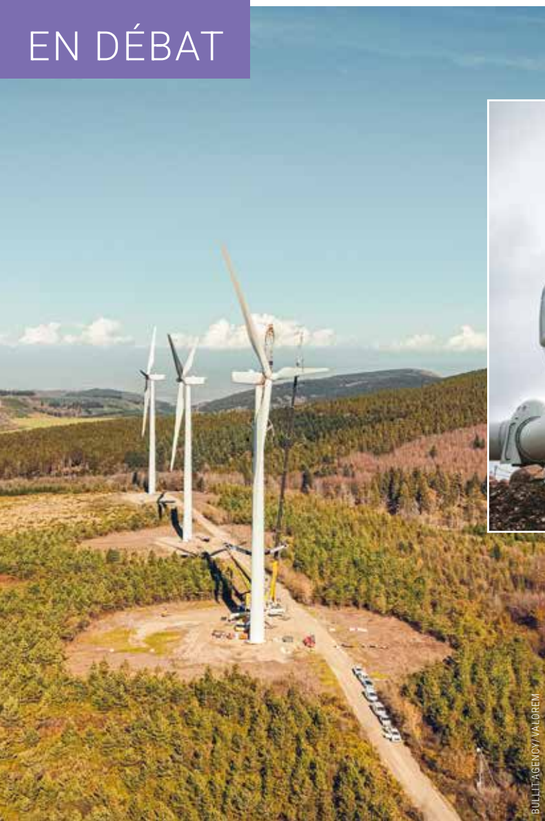
À Arfons-Sor, dans le Tarn, Valorem réalise une première française: le renouvellement d'un parc de onze éoliennes avec des pales reconditionnées par Vestas, là aussi à cause de contraintes de hauteur.
