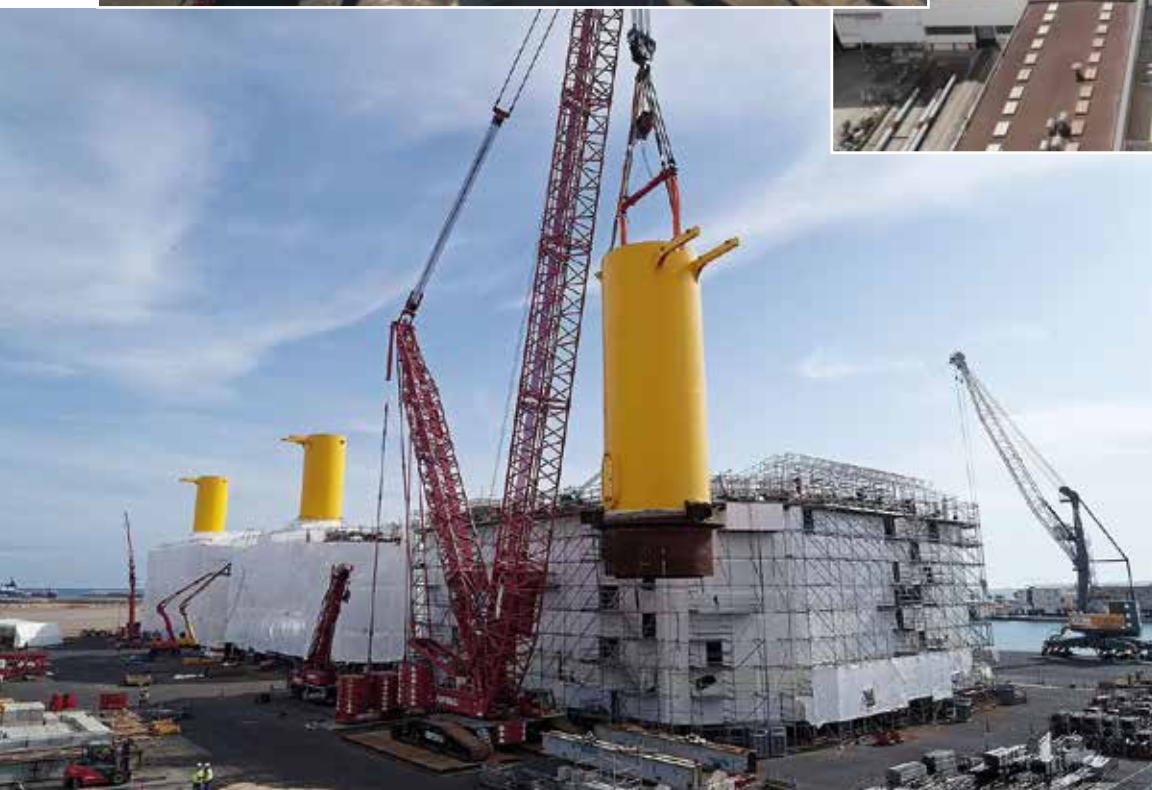
Assemblage des fondations des trois fermes pilotes flottantes en Méditerranée : Éoliennes flottantes du golfe du Lion (en haut à gauche), Provence-Grand Large (en haut à droite) et Eolmed (ci-contre).
