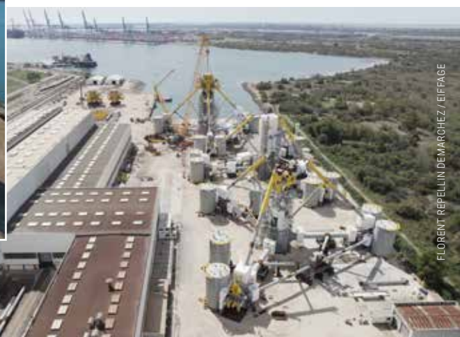
Assemblage des fondations des trois fermes pilotes flottantes en Méditerranée : Éoliennes flottantes du golfe du Lion (en haut à gauche), Provence-Grand Large (en haut à droite) et Eolmed (ci-contre).
